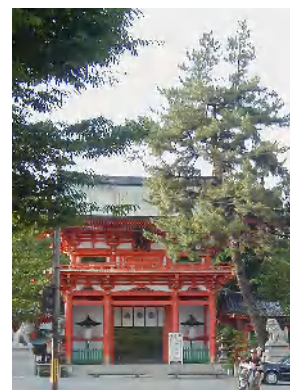
楼門（南側の今宮通沿い）
