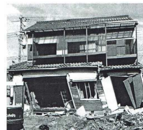
地震で大変形した建物 (日経アーキテクチュア編、阪神大震災の教訓【復興編】「地震に強い建築」、1995.8より)
