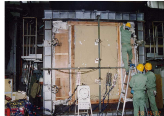
4) 木造土壁火災安全性実験
