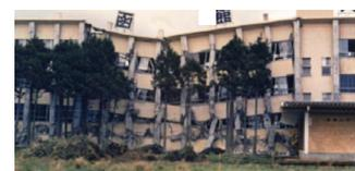
鉛直地震動による被害と推測される建物の破壊例(1968)
