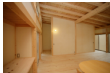
竹小舞下地土壁で次世代省エネ性能を 満たす小住宅の新築事例
