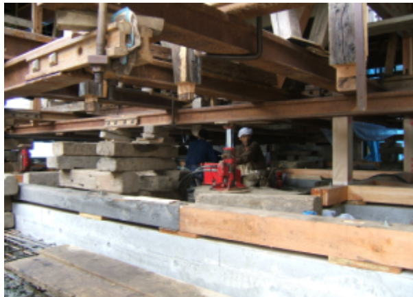
復興は、あせらず、あわてず、あきらめず。 築251年、新潟県中越地震で大規模な被害を受けた民家の修復工事
