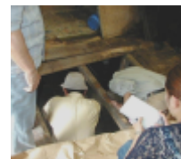
防火・耐震調査 (H14~)
