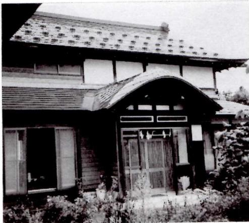
写真6 「アマヤ」形式の玄関、改装でアルミサッシの
