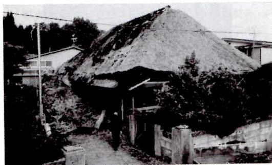
写真17 茅葺き屋根をほぐす「結」の共同作業
