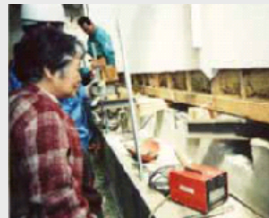
木造住宅の修復工事の公開
